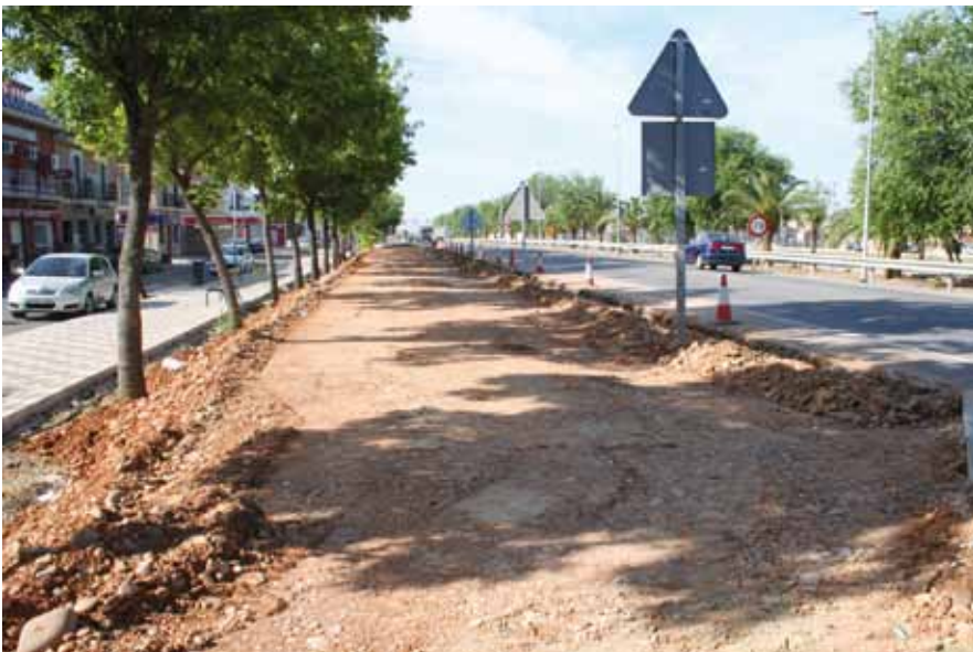
Construcción Carril Bici en Avda. de la Constitución
