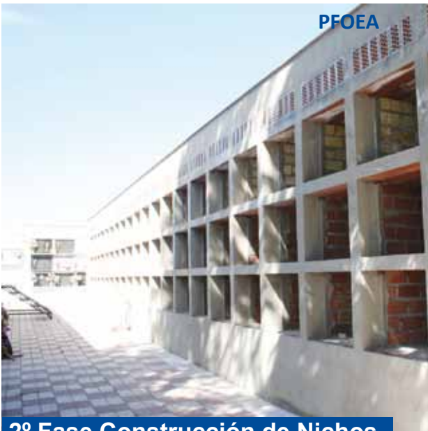
2º Fase Construcción de Nichos
