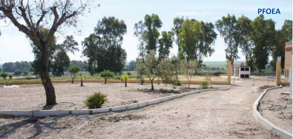
Cerramiento y construcción de accesos Parque de San Ignacio
