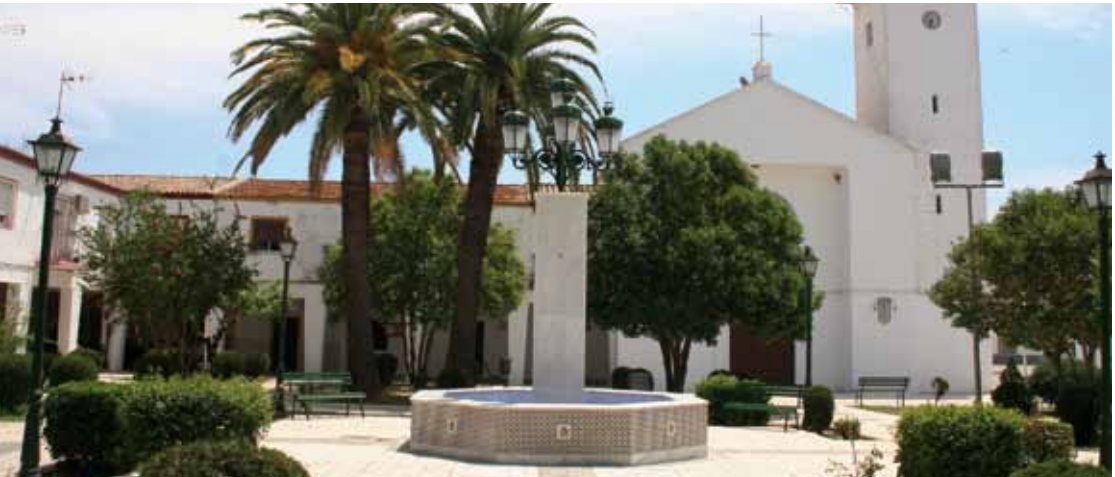
Construcción nueva fuente de la Plaza Mayor de El Viar
