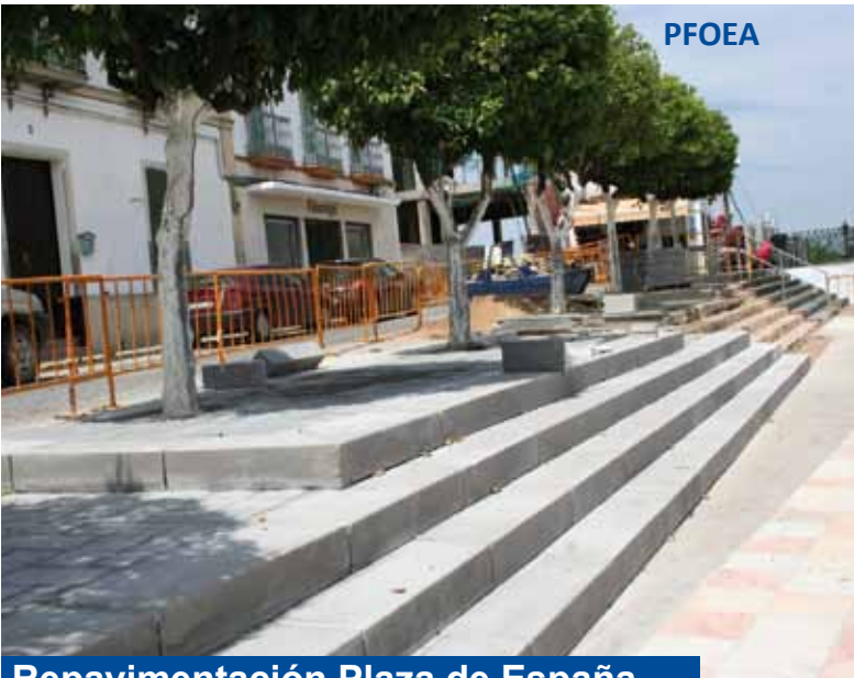
Repavimentación Plaza de España
