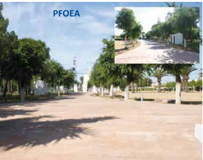
Construcción de nuevo acceso a la Iglesia y parque de Esquivel
