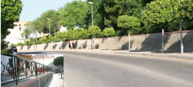
Adecantamiento Muro Avda. Antonio Machado
