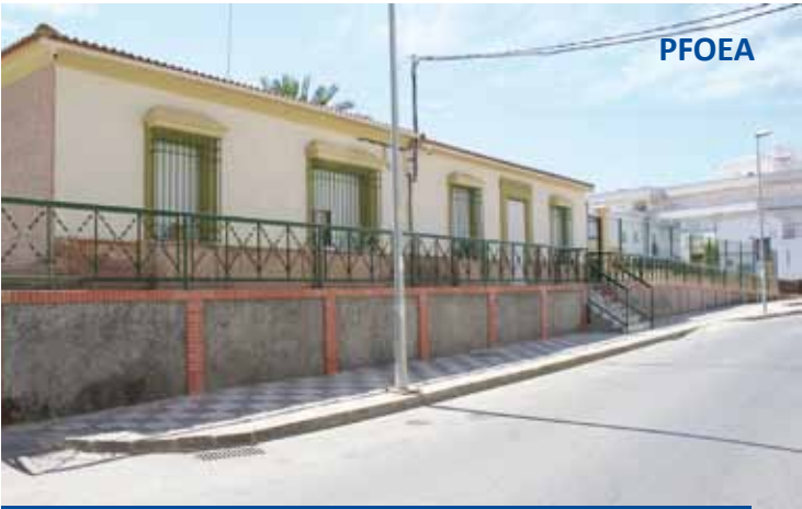
Muro y Vallado en Avda. de Andalucía
