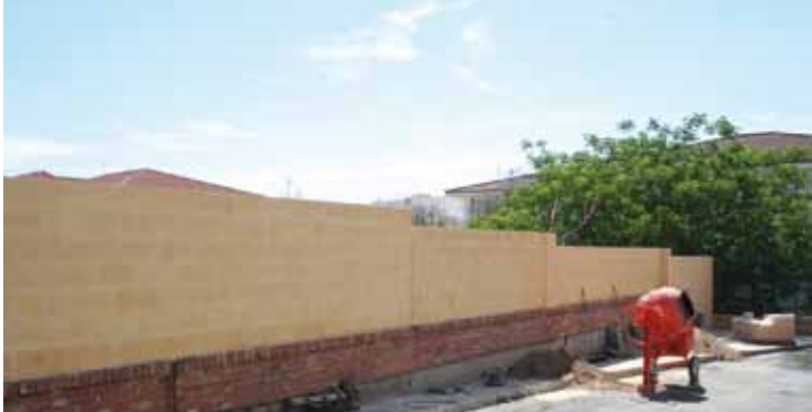
Construcción Muro de Seguridad en Instituto
