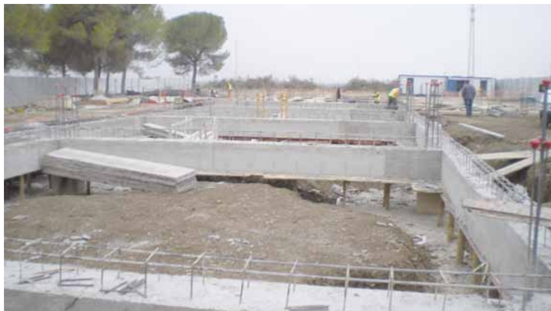
Primeras actuaciones en las obras del nuevo colegio esquivelense.
