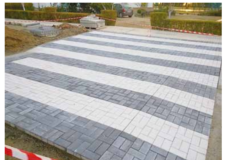
Nuevo badén construido en Esquivel.
